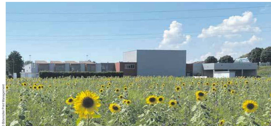
Die Hallenfertigstellung manifestiert für Bösmüller, „dass wir trotz Covid-19 immer den Blick nach vorn richten“.
